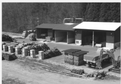
飯南町バイオマスセンター
