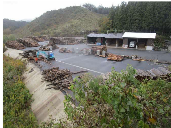
図 24 飯南バイオマスセンター
