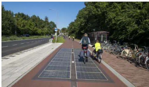
自転車専用道路への設置事例
