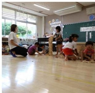
保育所の床板を全面張替え
