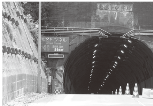
新設・改良が望まれる赤名トンネル
