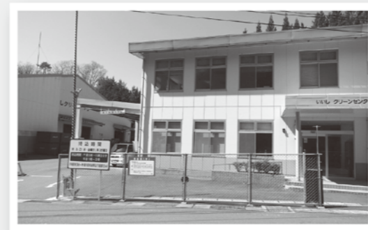
いいしクリーンセンターの外観
