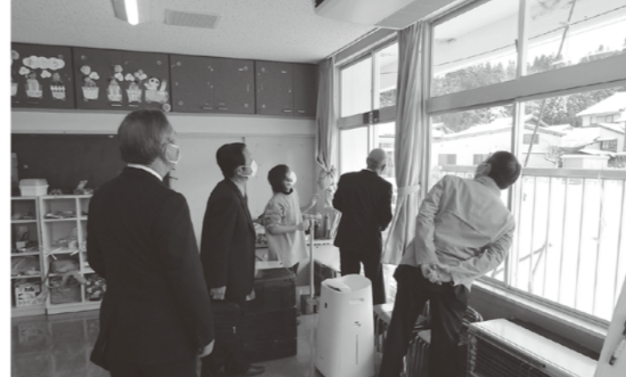
赤名保育所の雨漏りを視察
