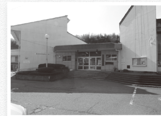
解体される旧来島基幹集落センター
