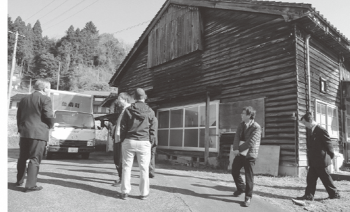
解体予定の旧谷保育所
