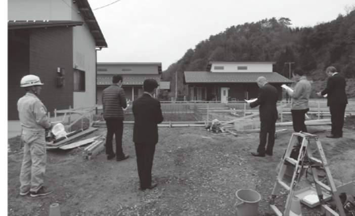
建設中の定住促進賃貸住宅(泉川)
