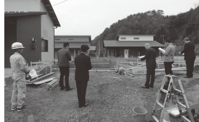
建設中の定住促進賃貸住宅(泉川)
