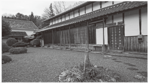
庭のある空き家
