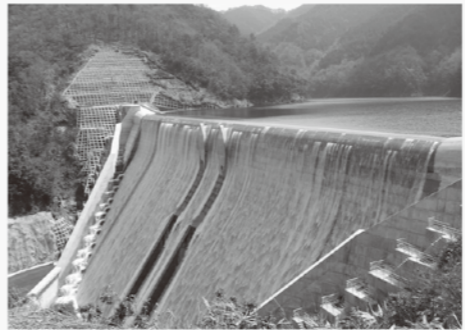
雄大な志津見ダム
