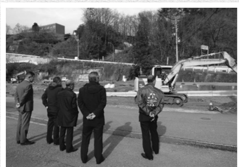
町道改良工事(頓原寺沢花栗線)
