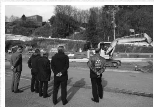
町道改良工事(傾原寺沢花栗線)
