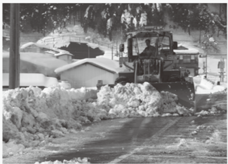
町内の除雪作業
