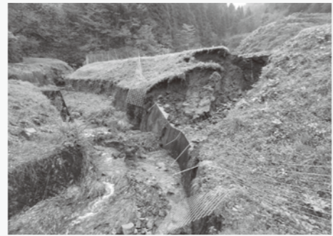
八神地区の法面崩落現場
