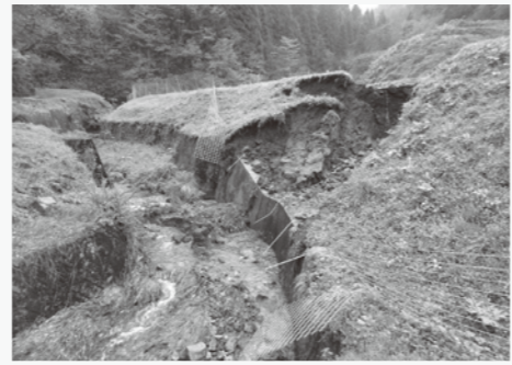
八神地区の法面崩落現場
