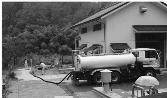
頓原浄化センター 汚泥搬出作業の様
