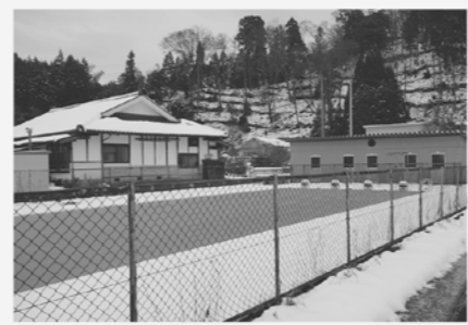
防火用水の役目もある旧小田小学校プール
