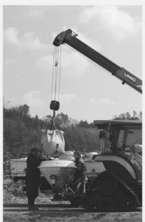
土改剤散布作業
