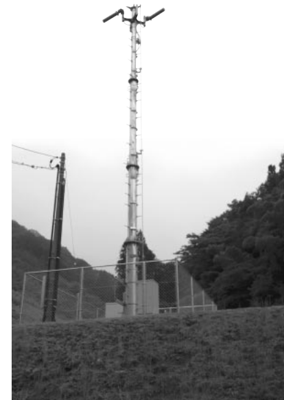
角井(伊比地区)通信鉄塔完成
