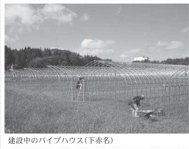
建設中のパイプハウス(下赤名)
