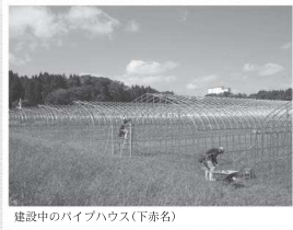
建設中のパイプハウス(下赤名)
