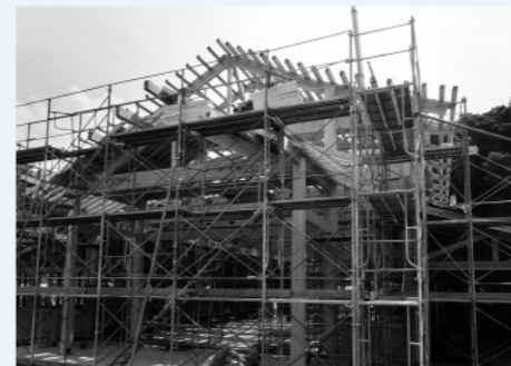
屋根工事が進む創作館
