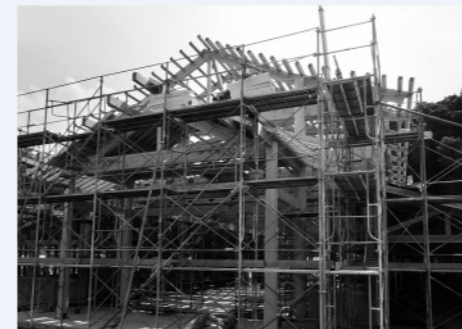
屋根工事が進む創作館
