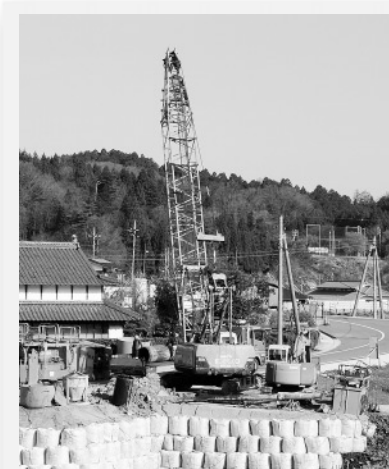
朽畑橋基礎工事
