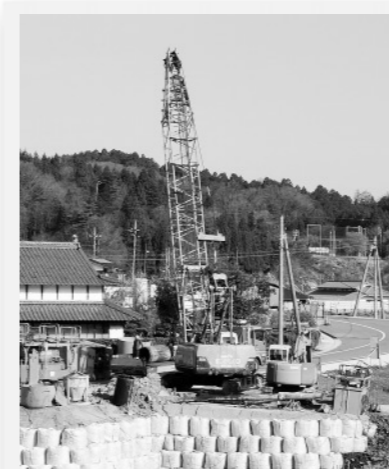
朽畑橋基礎工事
