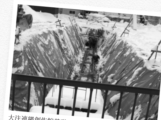
大注連縄創作館基礎工事
