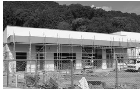
完成間近の交流物産館
