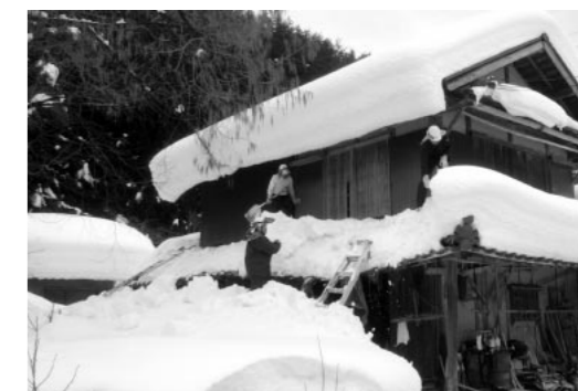
業者による雪下ろし作業
