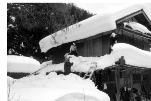
業者による雪下ろし作業
