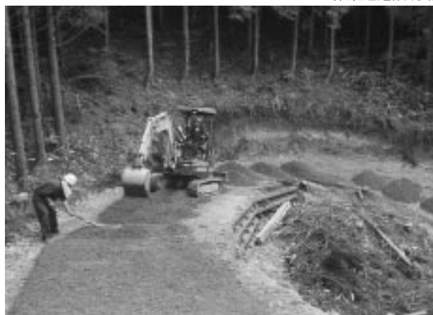
作業道建設現場
