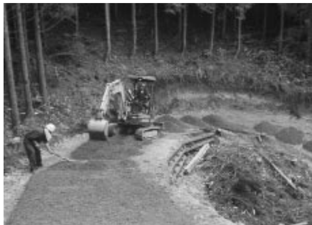
作業道建設現場
