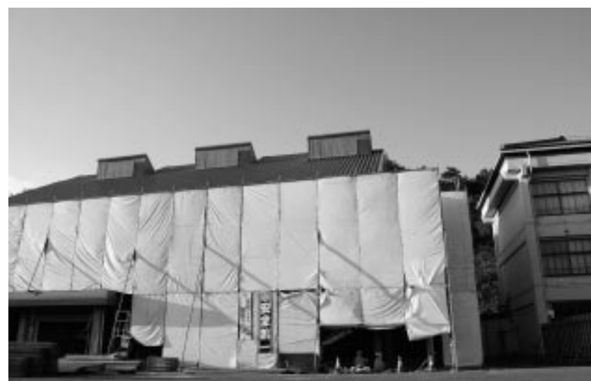
改修工事中の赤来中学校
