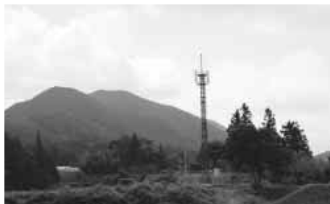
都加賀に設置された通信鉄塔
