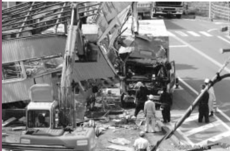
損害を受けた消防車格納庫(赤名)
