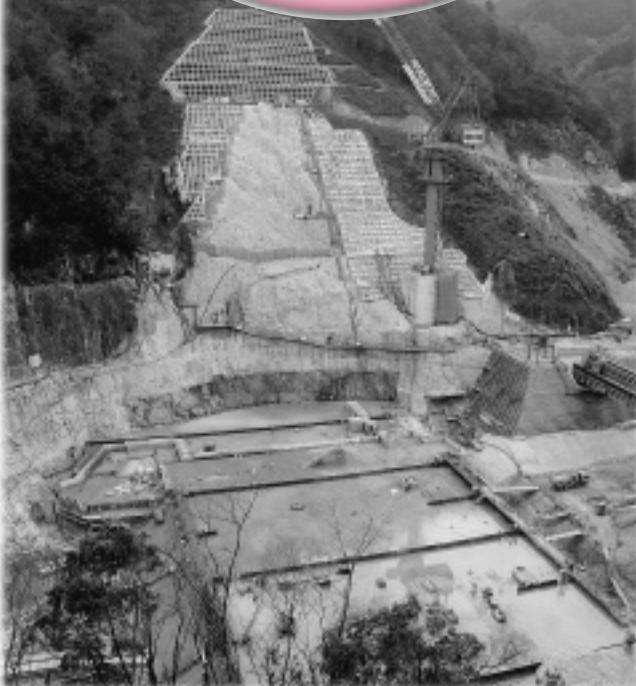
志津見ダム工事現場
