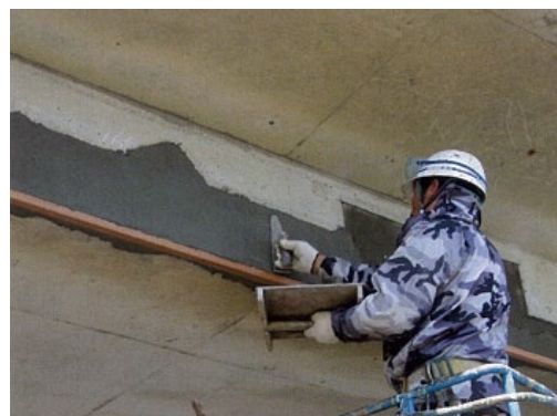
写真 4-3 断面修復状況
