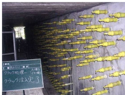
写真 4-2 ひび割れ注入状況
