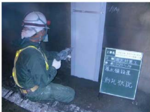
写真 3-2 線導水工
