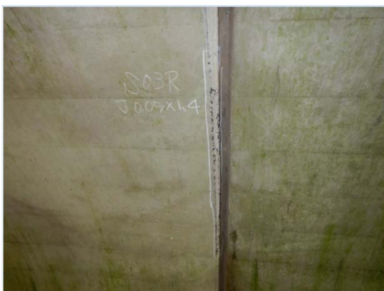
覆工（側壁）からの漏水
