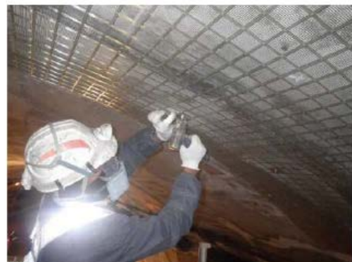
写真 3-1 FRP ネット設置状況
