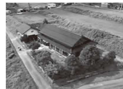
古民家を改装してはじめた体験型民泊「星の宿り」
