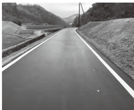
舗装を整備した町道頓原長谷線
