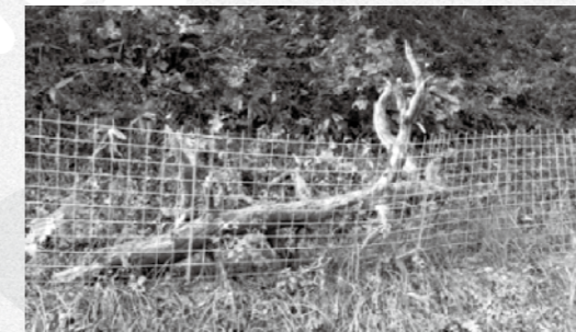
倒木によって破損したワイヤーメッシュ柵
