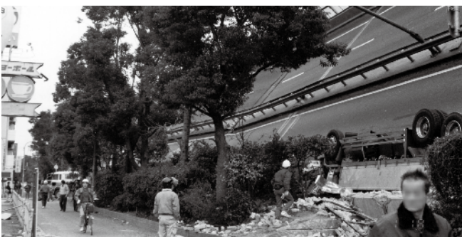
東灘区深江本町阪神高速倒壊現場(提供:神戸市)
