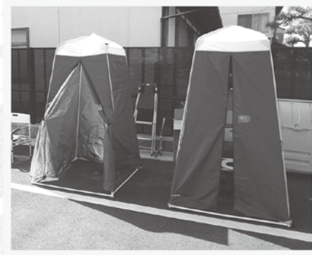
仮設便器の周りを専用テントで覆えば完成
