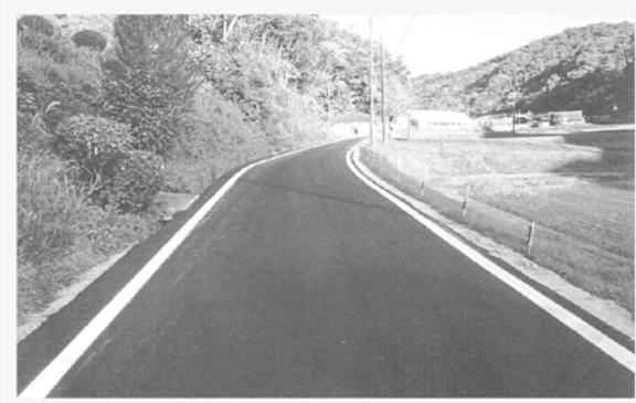
舗装がきれいになった町道頼原長谷線
