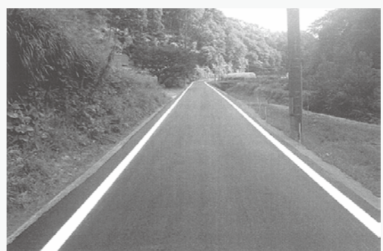
舗装がきれいになった町道頓原長谷線
