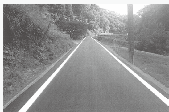
舗装がきれいになった町道頼原長谷線
