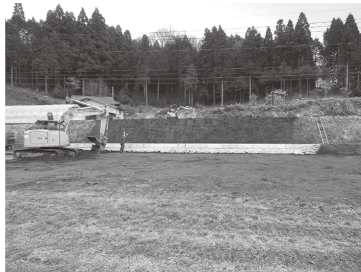
災害復旧工事
