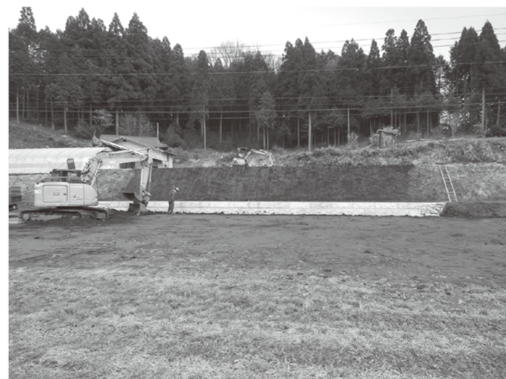
災害復旧工事
