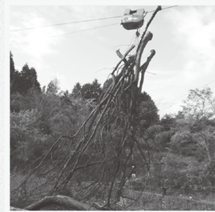
国内初導入となる海外製の架線機械 シンプルな作業が可能
