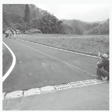
舗装がきれいになった町道頓原長谷線
